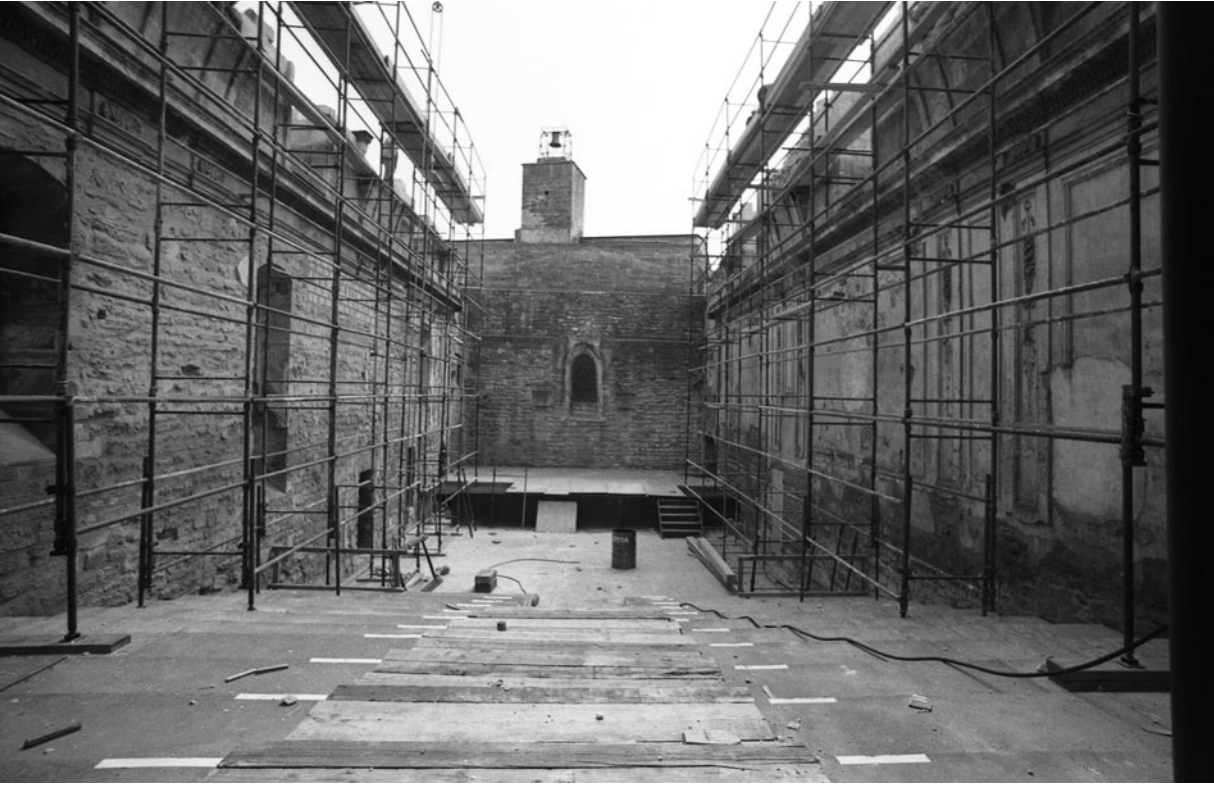
Tinel à ciel ouvert, début de la rénovation, 1978
